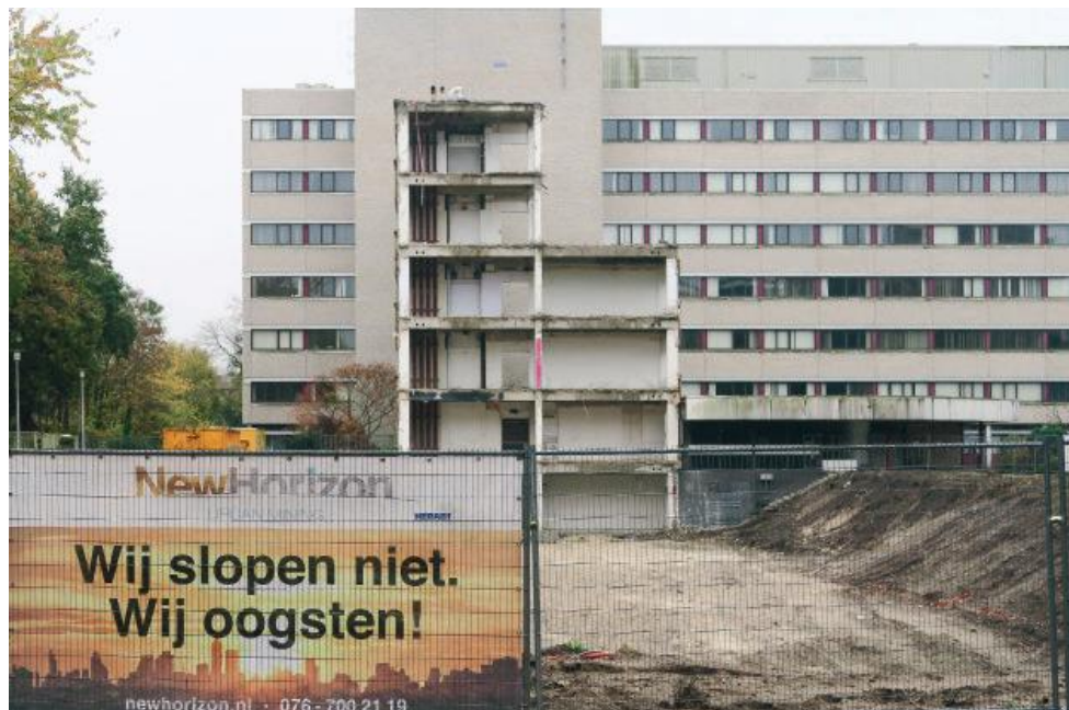
Voor de Alliantie ontmantelde New Horizon circa 9.000 vierkante meter van de kantoorgebouwen op het Lucent-terrein in Hilversum.
